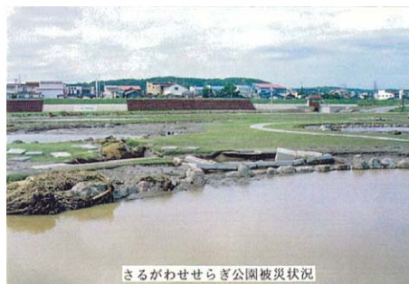
さるがわせせらぎ公園被災状況
