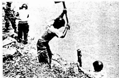
必死の護岸作業を行う自衛隊員 (昭和 36 年 7 月)
