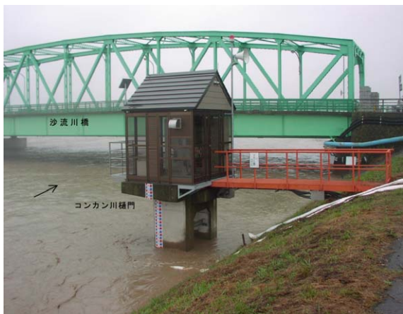
コンカン川樋門付近出水状況
