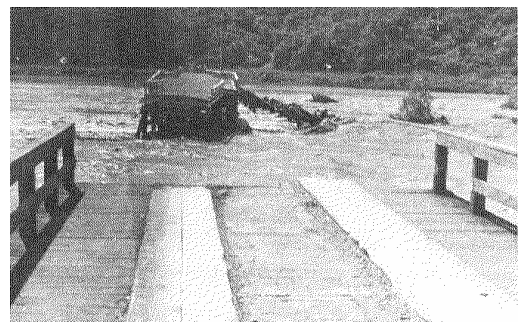
平取大橋の流失・平取町 (昭和30年7月)
