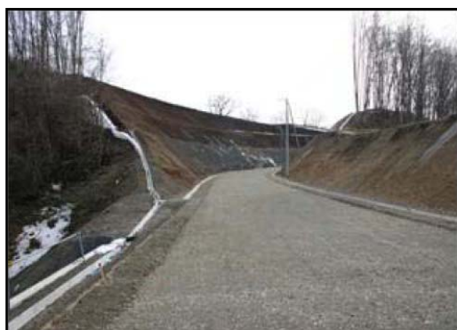
<工事完成直後>
