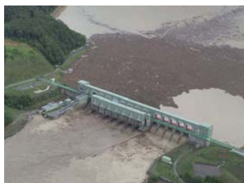
二風谷ダムの放流状況
