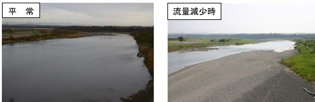
沙流川 KP2.8 (沙流川橋から上流)
