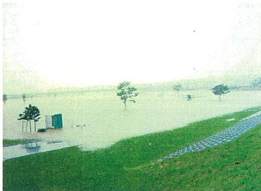
日高町門別地区せせらぎ公園浸水状況 (河川公園)
