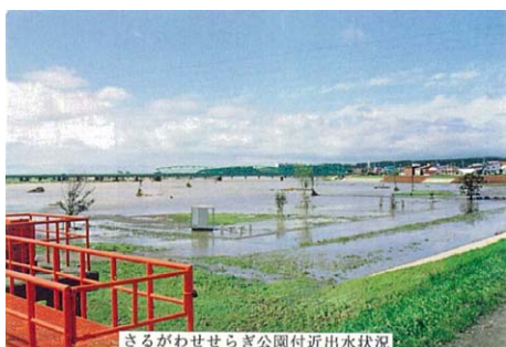
さるがわせせらぎ公園付近出水状況
