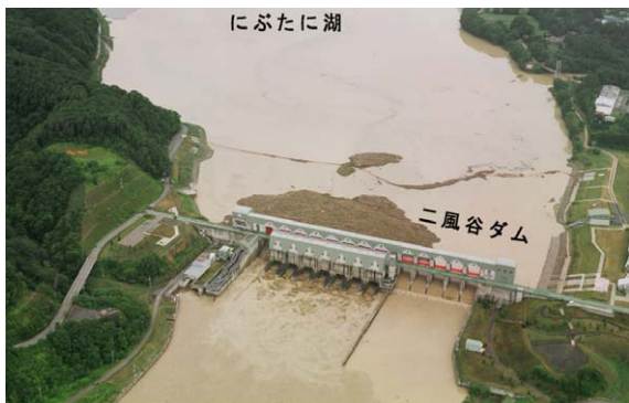
二風谷ダムの放流状況
