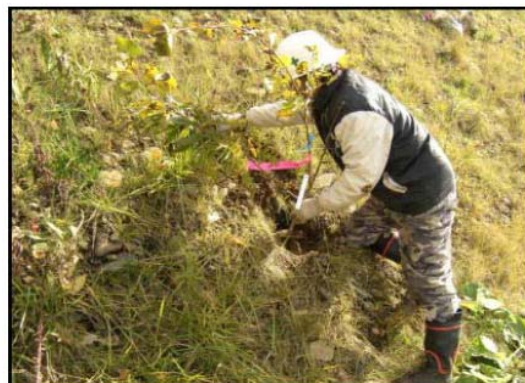
写真 3.2-1 道路法面の植栽状況
