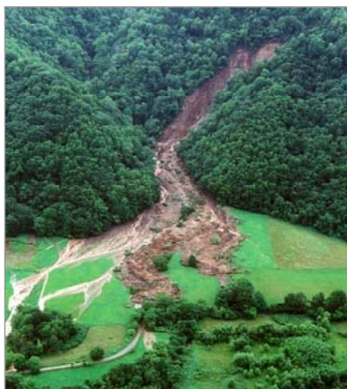
写真-1.1 斜面崩壊の状況
