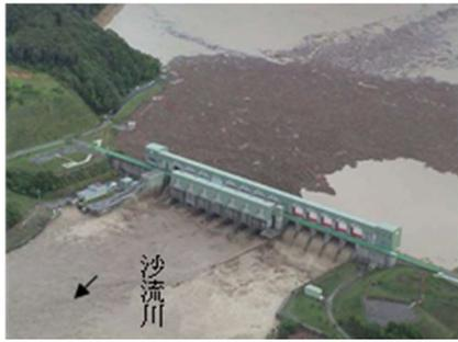
平成 15 年 8 月洪水 二風谷ダム洪水調節状況
