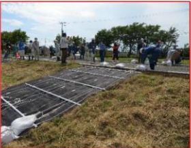
写真 2-34 シート張工法
