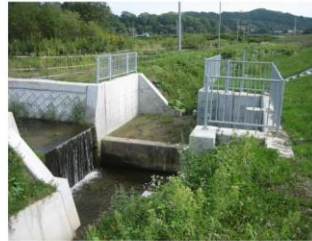
釜場の整備(上和泉2号樋門)
