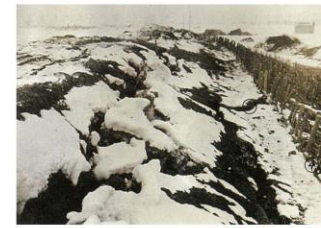
写真 1-20 豊城築堤の亀裂 (昭和27年(1952年)十勝沖地震)
