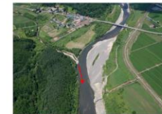
写真 2-7 鵜川中流部 (KP26.0 付近)
