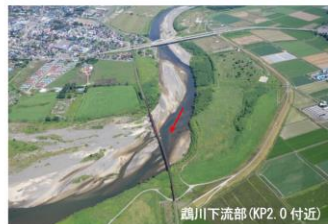
鵜川下流部 (KP2.0 付近)
