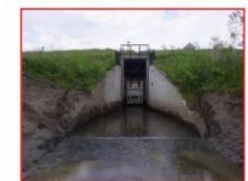
写真 2-32 堆積土砂掘削後
