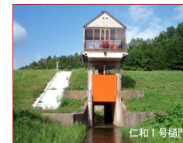
写真 2-3 浸水軽減対策(樋門の無動力化前) 写真 2-4 浸水軽減対策(樋門の無動力化後)
