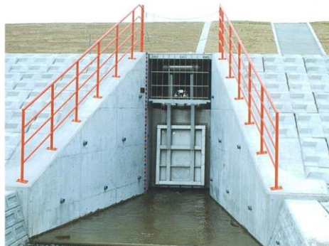
浸水被害軽減対策 樋門の自動化(豊城1号樋門)
