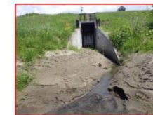
写真 2-31 堆積土砂掘削前
