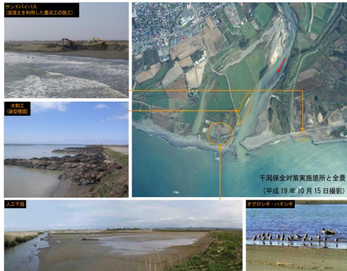
干潟保全対策実施箇所と全景
