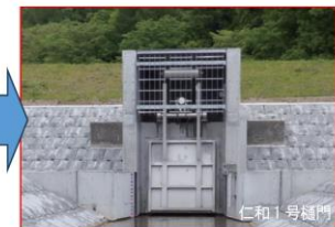
写真 2-3 浸水軽減対策(樋門の無動力化前) 写真 2-4 浸水軽減対策(樋門の無動力化後)
