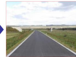
写真 2-24 堤防天端 補修実施後
