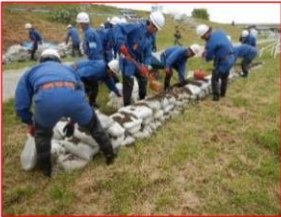
写真 2-33 防災機関による積み土のう工
