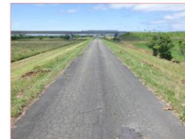
写真 2-23 堤防天端 補修実施前
