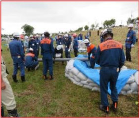
写真 2-35 月の輪工法
