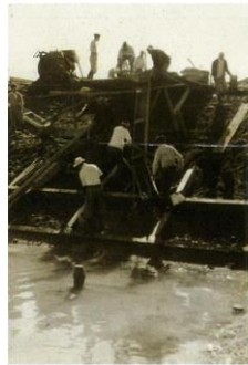
護岸工事(昭和27年)
