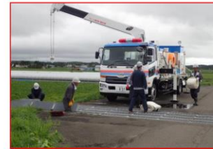
写真 2-1 ポンプ車による内水排除の状況 (汐見樋門、平成28年(2016年)8月洪水)
