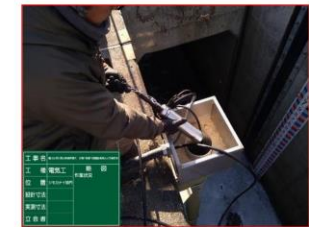
写真 2-28 水位計更新状況
