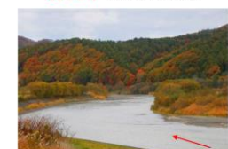
写真 2-10 旭生橋より下流
