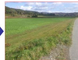
写真 2-26 生田築堤 堤防除草実施後
