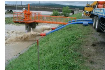
写真 1-25 ポンプ排水状況(穂別1号樋門、平成15年(2003年)8月洪水)
