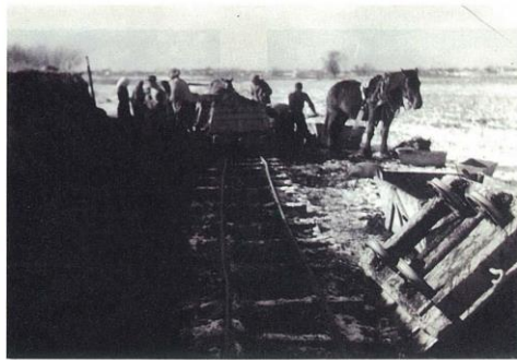
馬トロによる築堤盛土(豊城築堤)(昭和26年)
