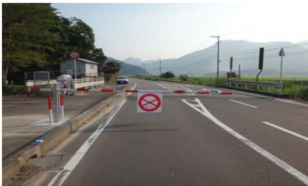
通行止め遮断機設置(閉鎖時)
