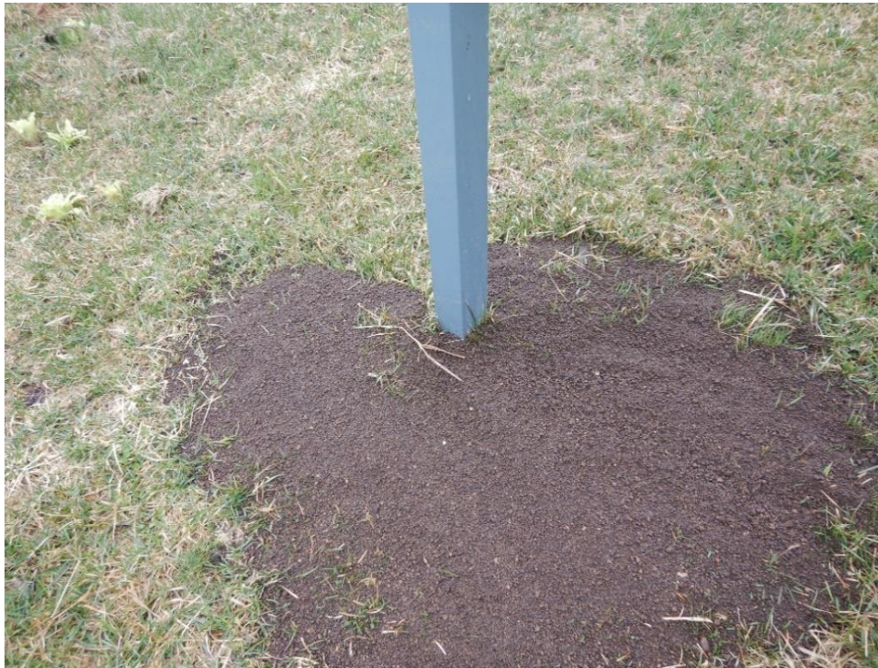
写真⑥-2 公園トイレ周辺(啓蒙看板)の基礎凹み(補修完了) @平取ダム
