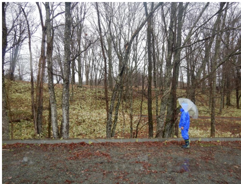
写真⑦-2 ノカピライウォロ標本園(管理棟周辺)の倒木(補修完了) @平取ダム
