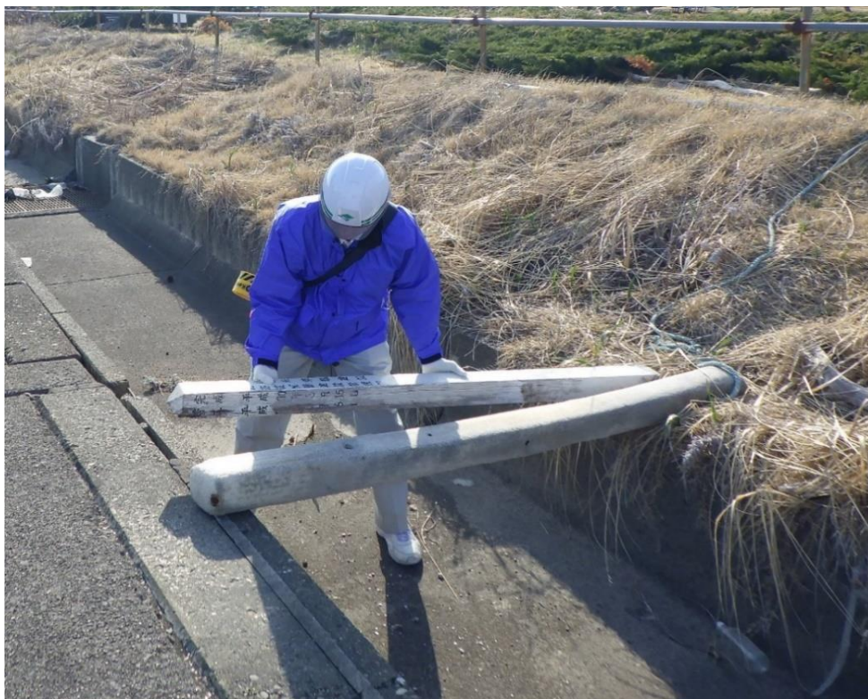
写真⑬ 支障物の撤去 @胆振海岸(白老萩野地区)
