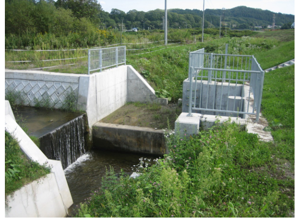
釜場の整備(上和泉2号樋門)
