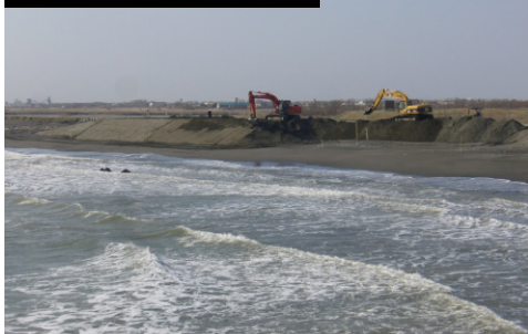
水制工 (袋型根固)
