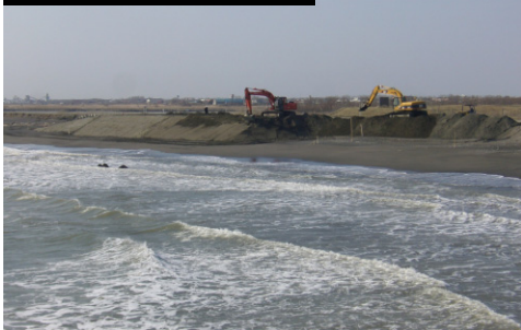
水制工 (袋型根固)
