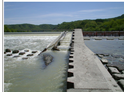
川東頭首工魚道
