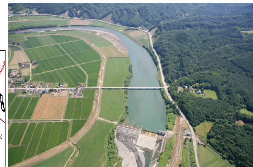
川東頭首工 (平成4年に魚道を設置)
