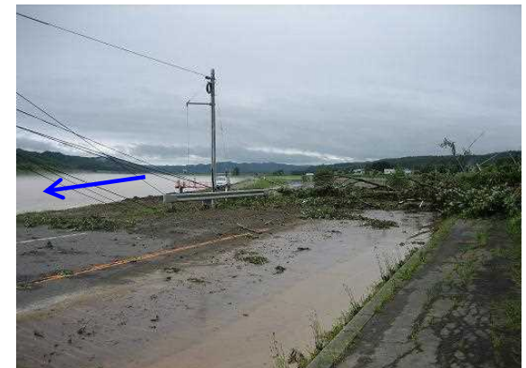
H18. 8道道穂別鵜川線土砂崩れ
