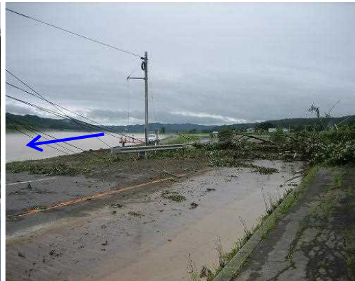
H18. 8道道穂別鵜川線土砂崩れ
