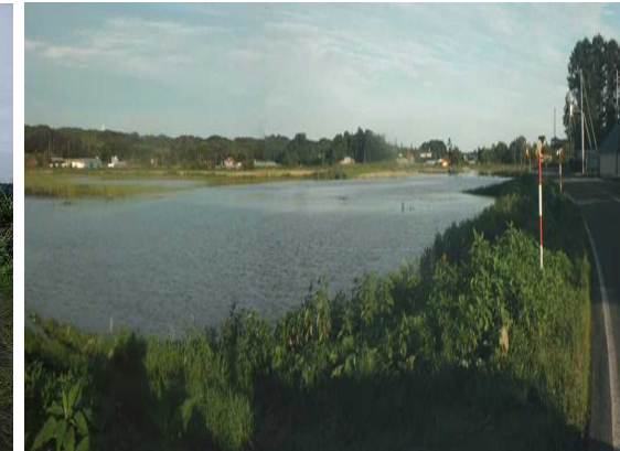
H28. 8入鹿別川内水氾濫
