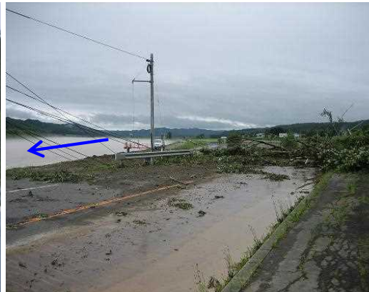
H18. 8道道穂別鵜川線土砂崩れ
