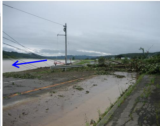
H18. 8道道穂別鵜川線土砂崩れ
