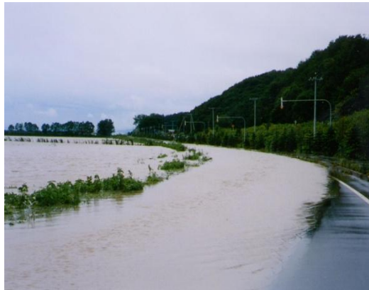
H13. 9道道米原田浦線冠水
