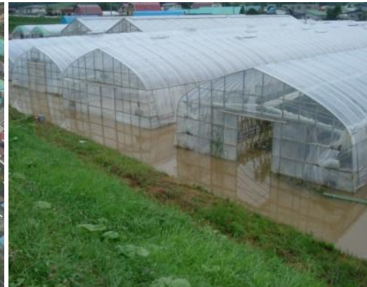
H18. 8平取町苺地区の浸水状況
