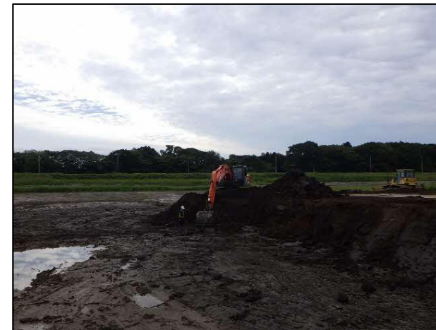
河道掘削（厚真川）
