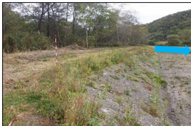
河道掘削 着工前(沙流川)
