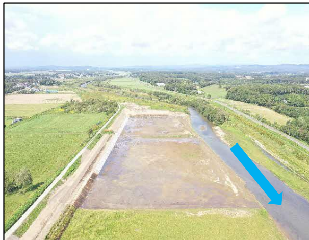
河道掘削 完成(厚真川)
