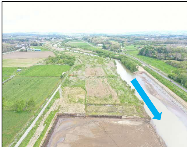
河道掘削 着工前(厚真川)
