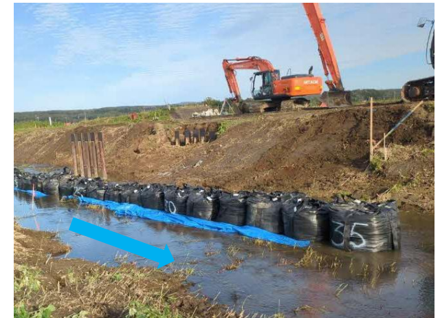
河道掘削 (入鹿別川)
