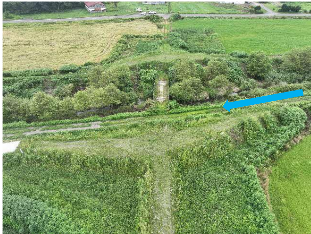
河道掘削 着工前(入鹿別川)橋梁工
