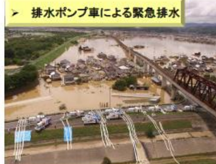
【H30.7月豪雨】 (岡山県倉敷市真備町)
