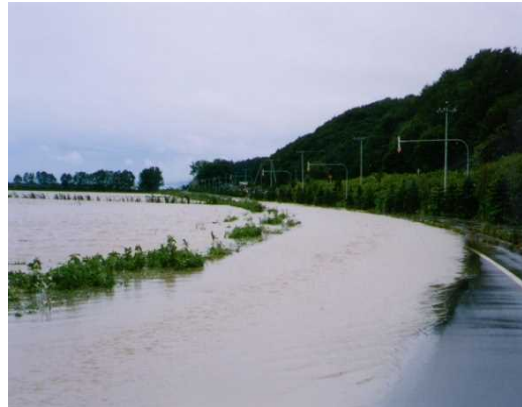
H13. 9道道米原田浦線冠水
