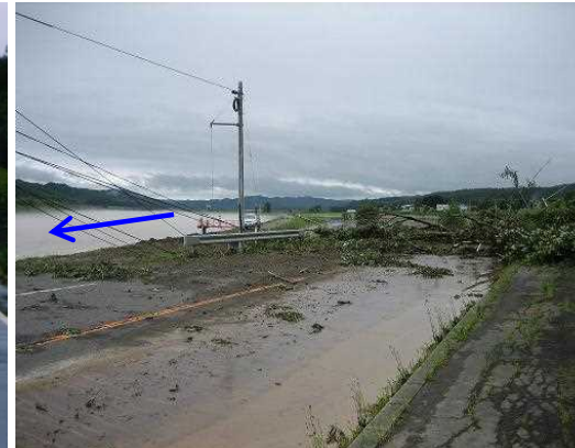
H18. 8道道穂別鵜川線土砂崩れ
