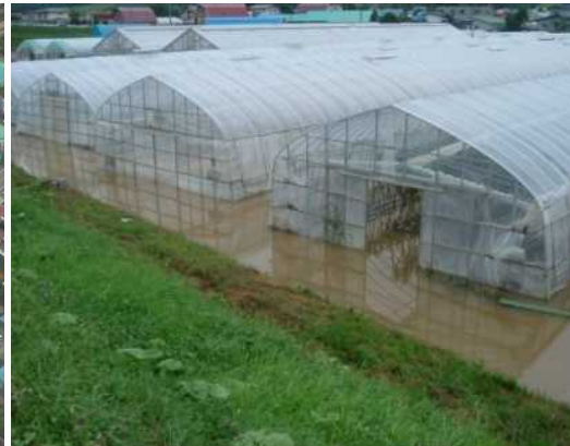
H18. 8平取町苺地区の浸水状況
