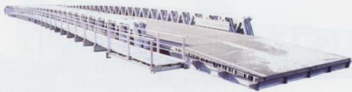
災害等により橋梁が流出又は損傷して通行不能となった場合に、短期間で応急的に組立・架設をすることにより道路機能を確保することを目的としたものです。H28年の台風で被災したR273高原大橋の迂回路の仮橋として、約2年間にわたり設置されました。
