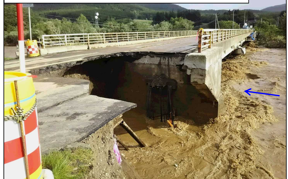
国道38号 太平橋の被害状況
