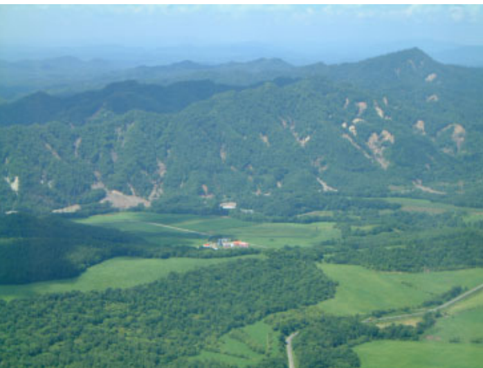
厚別川上流域の崩壊地の状況 平成15年8月13日午前撮影
