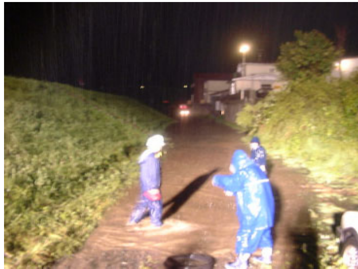
栄町コンカン地区 水防活動(ポンプ排水)の状況 (河口から約3km) 平成15年8月9日夜間撮影
