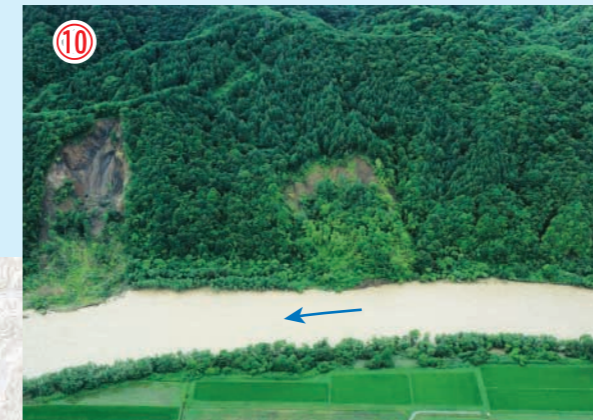
⑩ 斜面の崩落した栄地区 ：平成15年8月10日午前11時頃撮影
