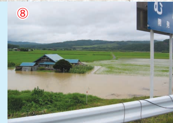
⑧ 浸水した旭生橋付近の家屋 ：平成15年8月10日午前7時頃撮影
