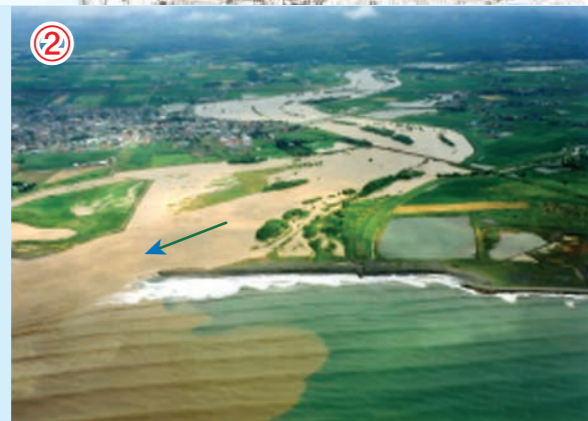
② 鶴川河口出水状況 ：平成15年8月10日午前11時頃撮影
