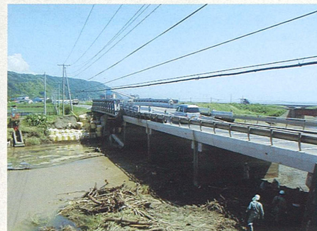
応急復旧完了
