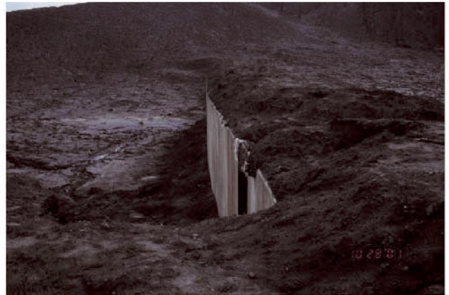
2000年噴火の際の泥流を防いだ砂防えんてい（ダム）
