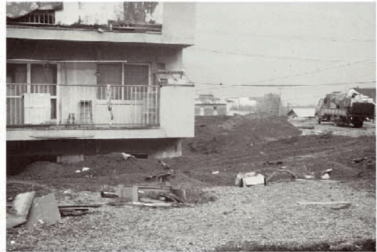
1977～78年噴火後の泥流に襲われた町営住宅 1階が完全に埋まっている。(北海道大学図書刊行会)
