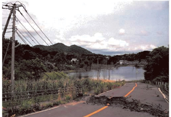
地面が圧縮されたためアスファルトが盛り上がり、電線がたるんだ
