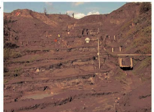
多くの断層により階段状になってしまった国道230号
