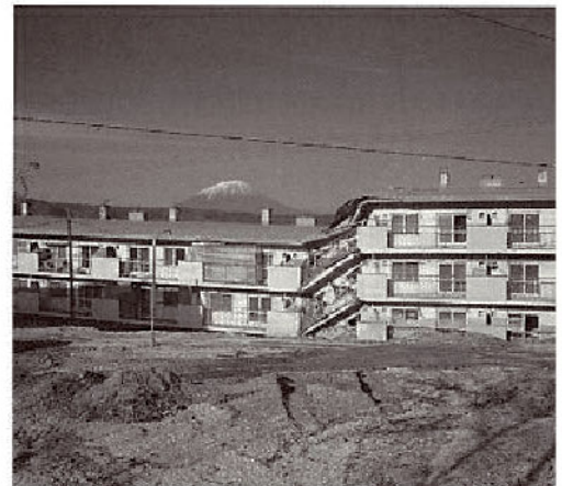
断層で切断されそうになったアパート (北海道大学図書刊行会)
