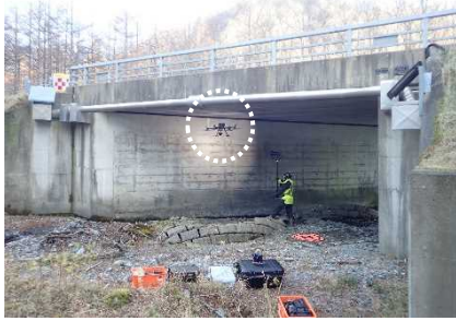
ドローンによる橋梁の点検状況 (国道236号 木屋の沢橋)
