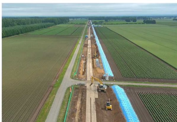
整備中の用水路（芽室川西地区）
