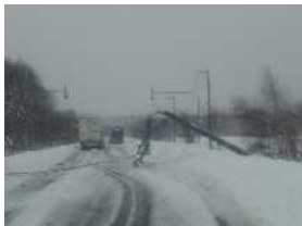
暴風雪による電柱の倒壊 (大樹町 国道336号)
