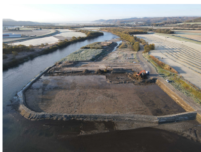
▲河道掘削の状況
