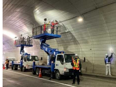
トンネルの点検状況 (国道273号 龍門トンネル)
