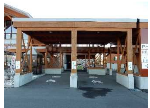
屋根付き駐車スペース 道の駅「ピア21しほろ」
