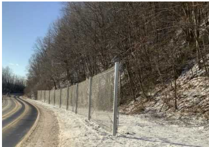
法面・盛土の防災対策 (国道242号 陸別町)
