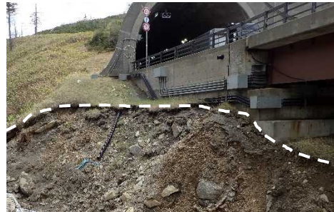
河川に隣接する道路構造物の流失防止等の対策 (国道274号 清水町)
