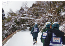
被災状況調査(石川県輪島市)
