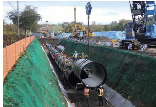
用水の安定供給に向けて管の布設作業
