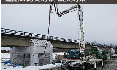
地震による被害を最小限に抑える耐震補強(豊頃大橋)
