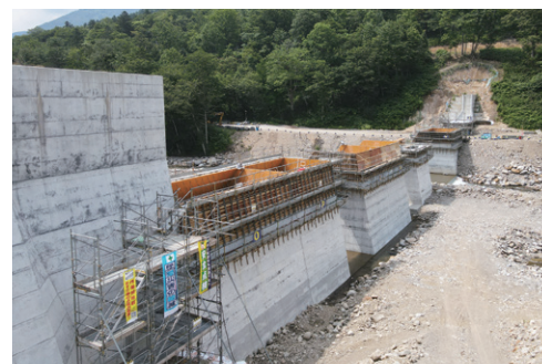
戸鶯別川第4号砂防堰堤(建設中)
