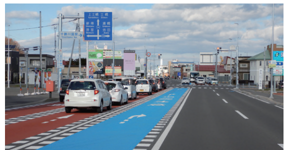
国道241号 音更大通(交通安全対策・無電柱化)
