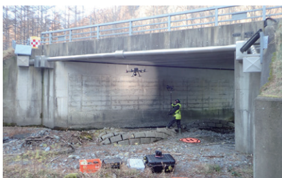
ドローンによる橋梁点検（国道236号 木屋の沢橋）
