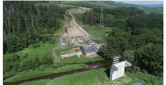
北海道横断自動車道(足寄～北見)の整備
