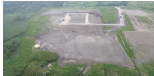
河道掘削土を活用した一時避難場所の造成(豊頃町)
