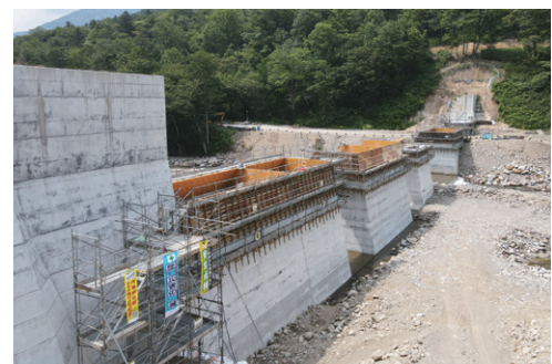
戸鷹別川第4号砂防堰堤(建設中)
