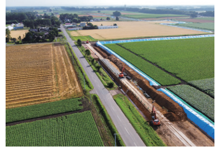
用水管路の布設状況 (芽室川西地区 帯広市)
