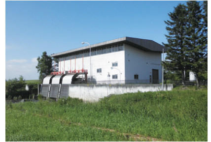
整備が待たれる排水機場 (新川二期地区 幕別町)
