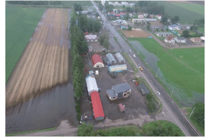
整備前の湛水被害状況 (笹川地区 鹿追町)
