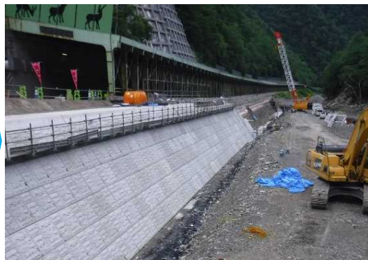
覆道基礎の復旧完了 (H29.8.1撮影)
