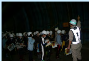
トンネル内で施工方法を説明。一生懸命メモをとる生徒たち
