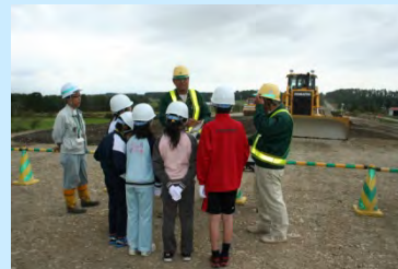
土砂運搬⇒フルーザーによる敷均⇒ローラー転圧と一連の流れを見学
