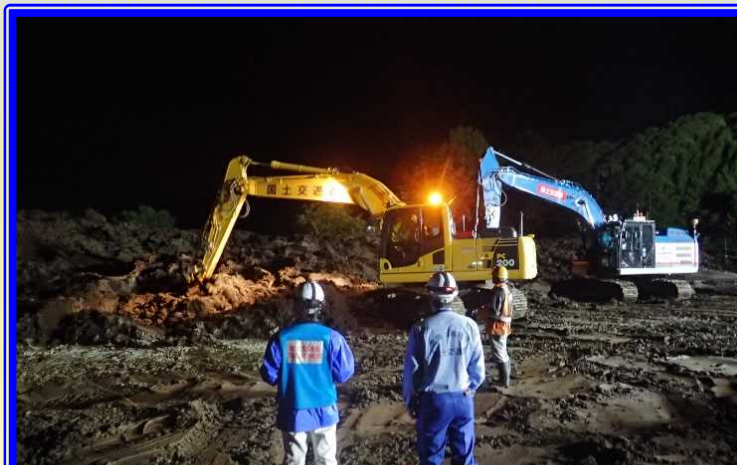
H30.9 胆振東部地震による 河道閉塞土砂撤去状況(厚真町)
