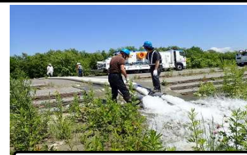
災害対策用機械操作訓練
