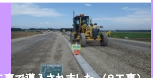
マシンコントロールによるブルドーザ路盤材敷均し作業
