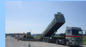
再生路盤材運搬(L=37km)車両を積載2.5倍のトレーラーダンプを使用
