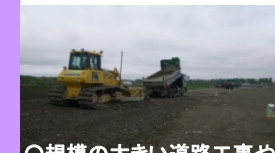
マシンコントロールによるブルドーザ路盤材敷均し作業
