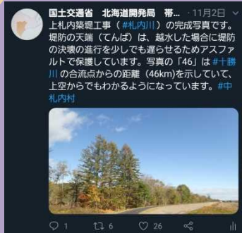
事業紹介 河川 天端舗装
