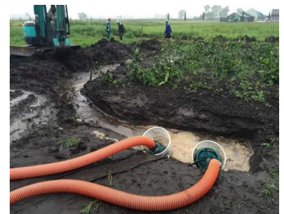
溝切り、ポンプ排水状況 平成28年8月31日撮影
