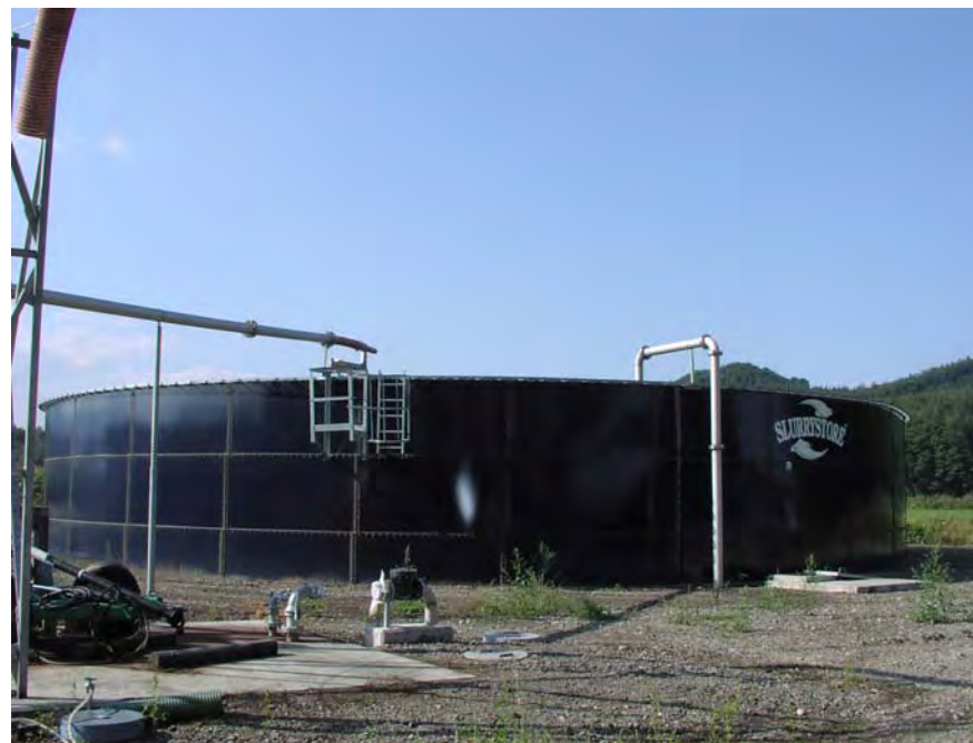
スラリーを貯留するための共同調整槽
