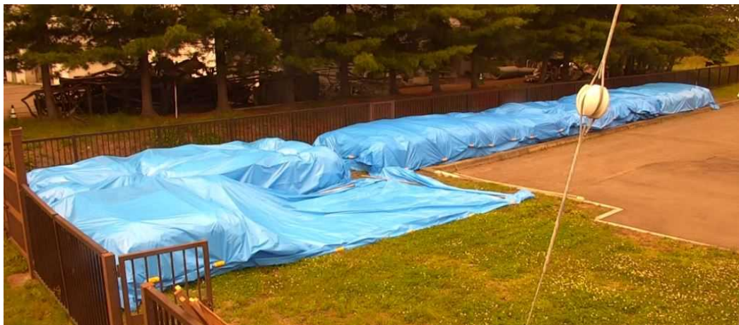
土砂撤去の作業状況②
