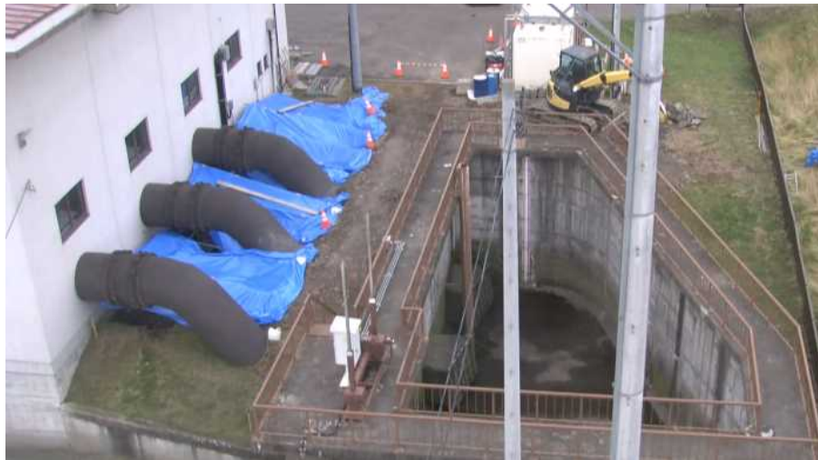
土砂撤去の作業状況①
