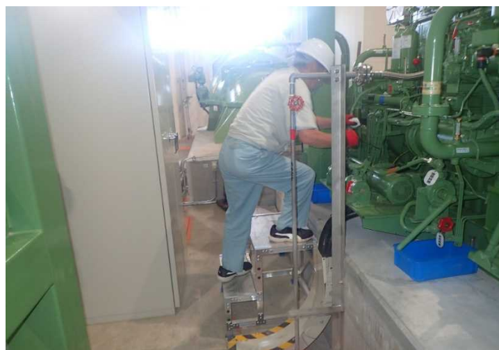
定期点検の作業状況（7/26撮影）
