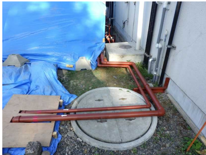
仮設燃料配管の敷設状況（7/26撮影）
