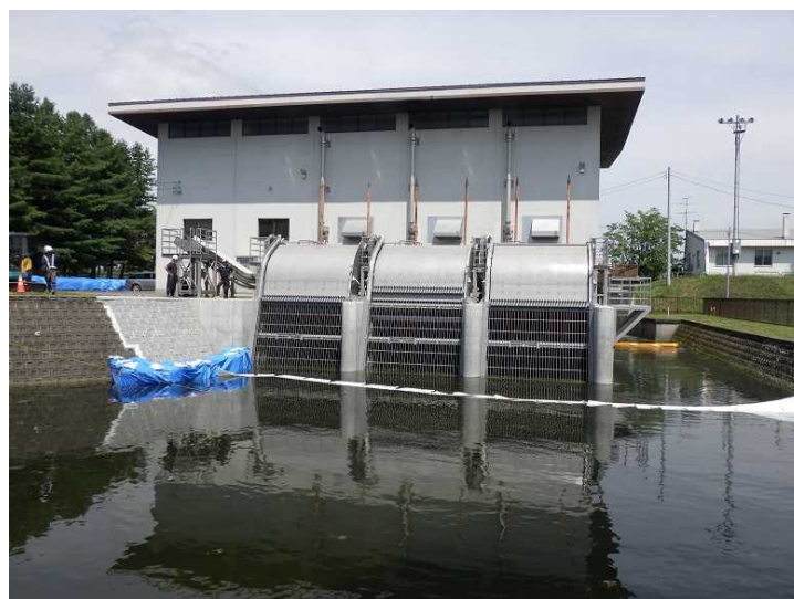
定期点検に伴う水位上昇状況（7/27撮影）
