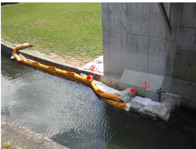
染み出し対策箇所①②の状況 (7/25撮影)
