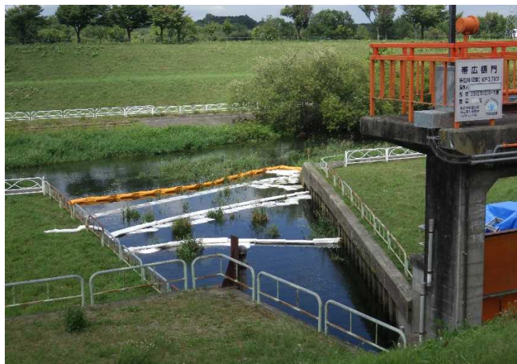
オイルフェンス設置状況 (7/25撮影)
