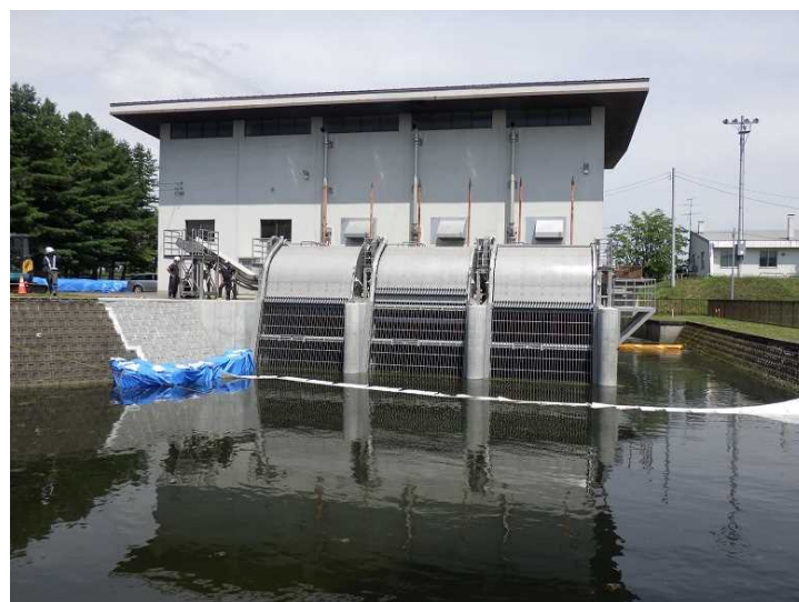
定期点検に伴う水位上昇状況（7/27撮影）
