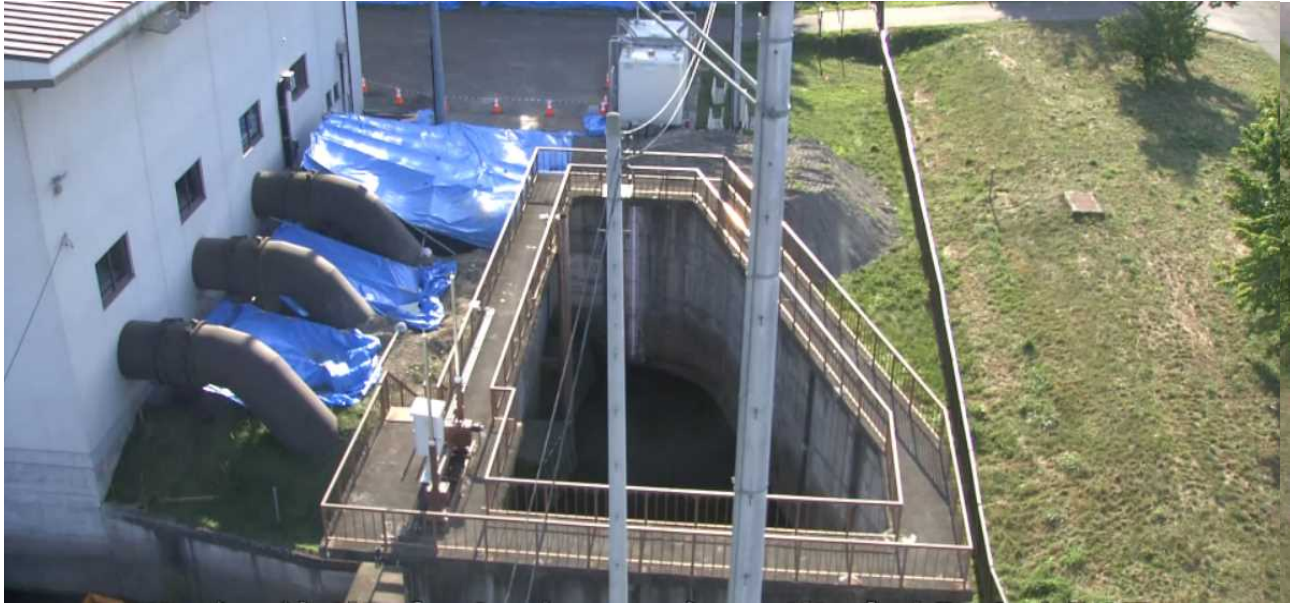
撤去土砂174袋分の仮置状況 (8/2撮影)
