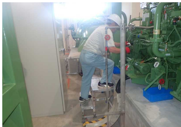
定期点検の作業状況（7/26撮影）
