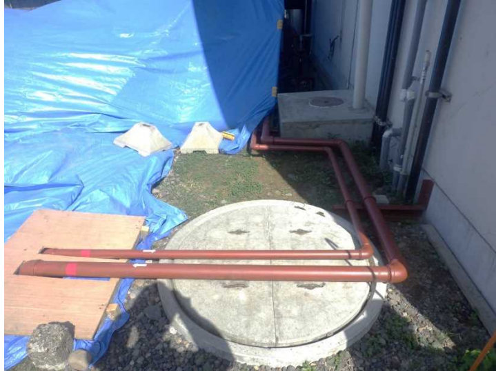
仮設燃料配管の敷設状況（8/2撮影）
