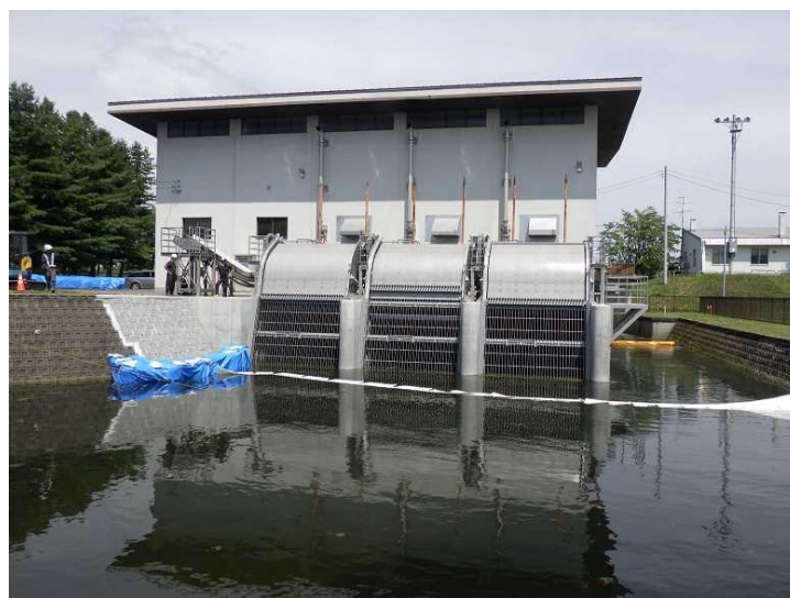
定期点検に伴う水位上昇状況（7/27撮影）
