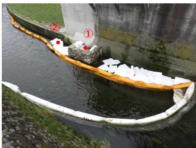
染み出し対策箇所①②の状況 (8/30撮影)
