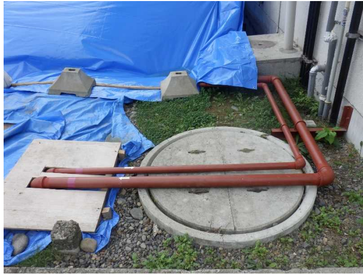
仮設燃料配管の敷設状況（8/29撮影）
