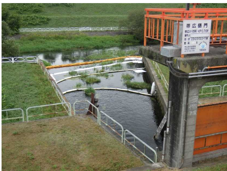
オイルフェンス設置状況（8/30撮影）
