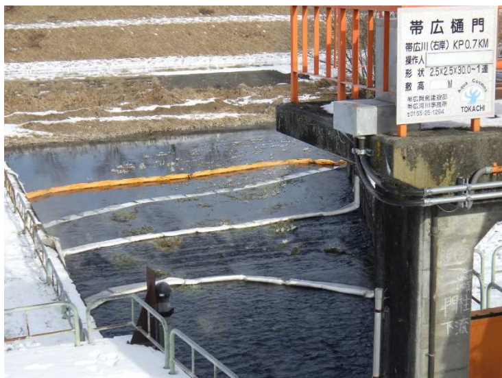
オイルフェンス設置状況 (12/26撮影)
