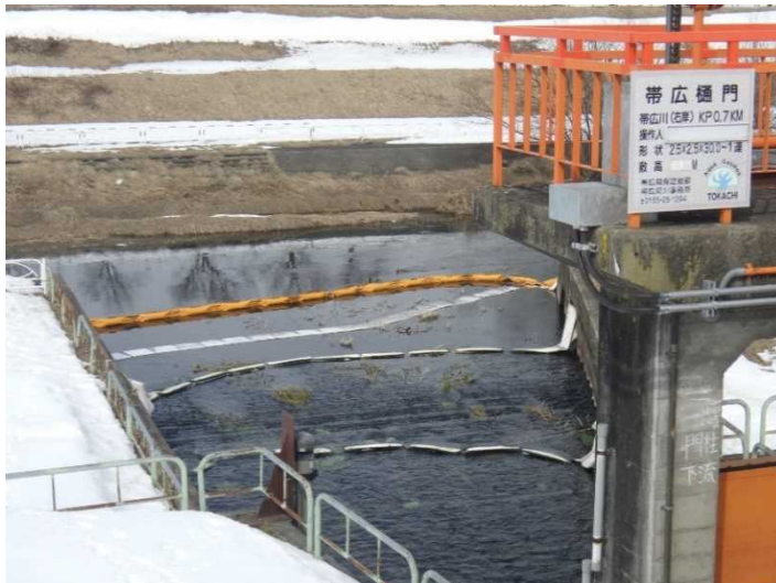
オイルフェンス設置状況（3/21撮影）
