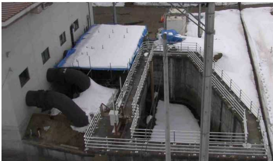
土砂撤去箇所の状況（3/21撮影）
