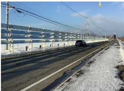
防雪柵設置 (国道274号 鹿追町)
