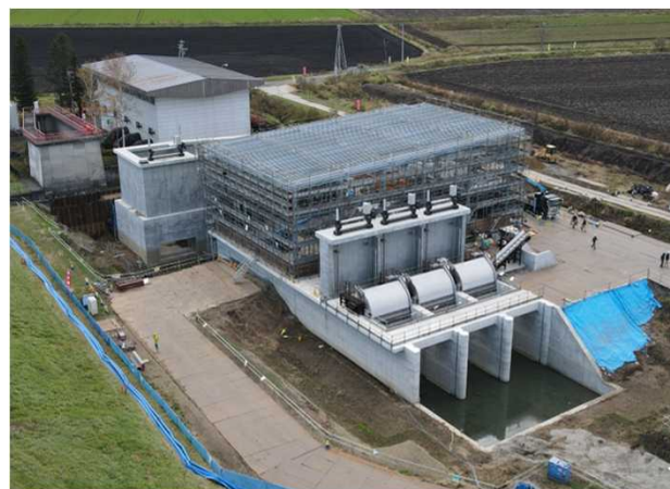
整備中の排水機場（新川二期地区）
