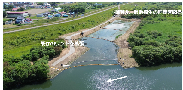
▲水際環境(ワンド)施工中
