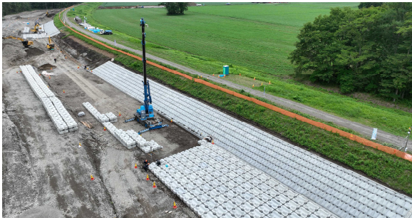
▲堤防保護対策の施工状況
