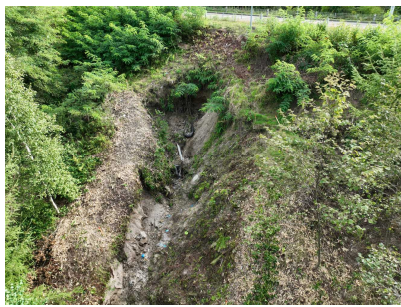
法面・盛土の防災対策 (国道241号 足寄町)
