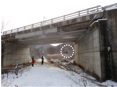
ドローンによる橋梁の点検状況 (国道242号 深雪跨線橋)
