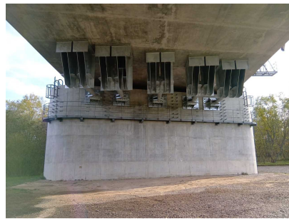
橋梁の耐震補強 (国道236号 芽室町)
