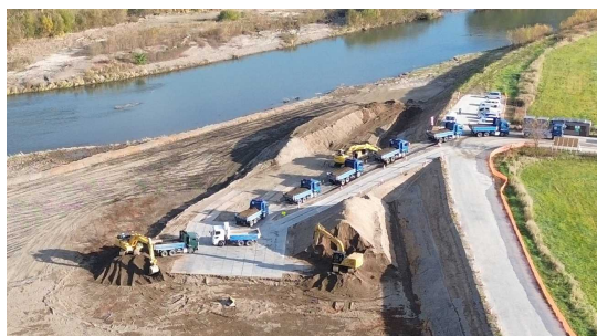
▲河道掘削の状況
