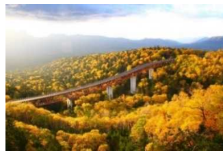
国道273号 三国峠 (松見大橋)
