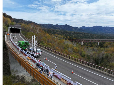
橋梁補修状況 (国道273号 コマクサ橋)
