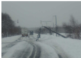
暴風雪による電柱の倒壊 (大樹町 国道336号)
