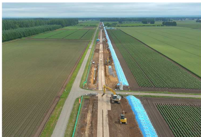
整備中の用水路（芽室川西地区）
