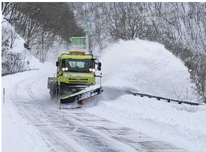
除雪作業 (国道236号 広尾町)
