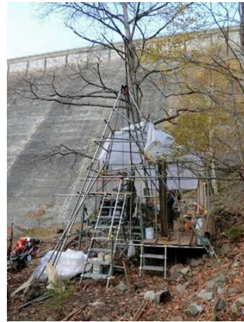
▲糠平ダム直下での岩盤地質調査
